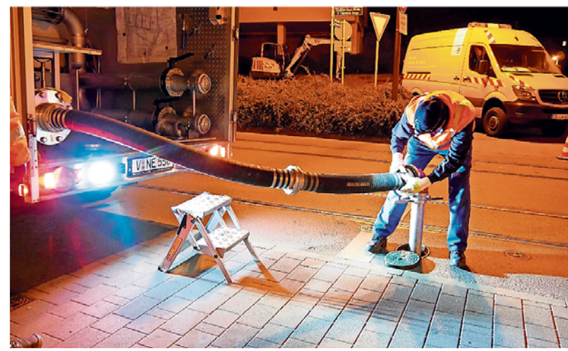
Unterstützt von Spezialfirmen spült die LWG regelmäßig das Trinkwassernetz, um es von Ablagerungen zu reinigen, wie jüngst bei der nächtlichen Aktion in Mitte. FOTO: LWG
